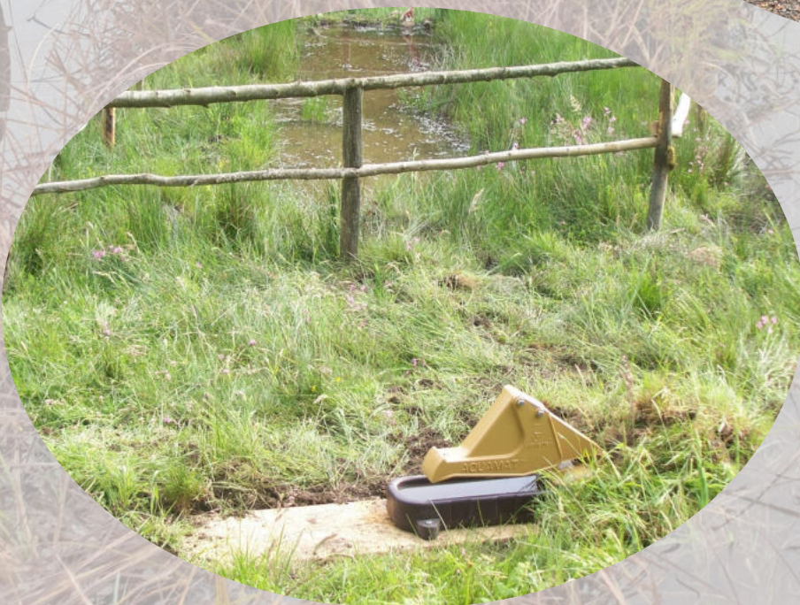
Mise en place d'une pompe à museau
