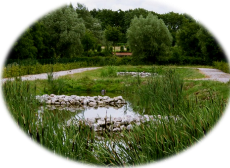
Le lagunage naturel reprend le fonctionnement d'auto-épuration des zones humides
